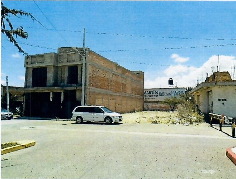
PREDIOS AFECTADOS POR CALLE ADOLFO RUIZ CORTINES.
